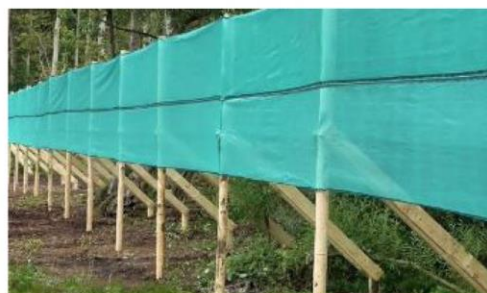
Een vleermuisscherm is een scherm van fijnmazig raster op hoogte. Hiermee bootsen we de geleiding van de gekapte bomen na.
